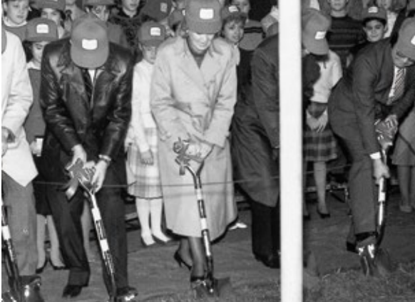
Ambrake Corporation 建設地での鉄入れ式(1986)
