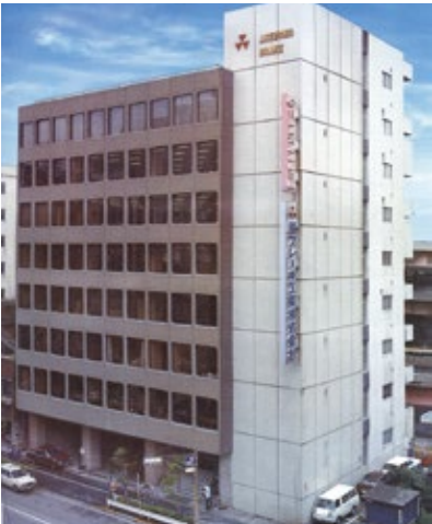
日本橋に建設した本社社屋(1971)
