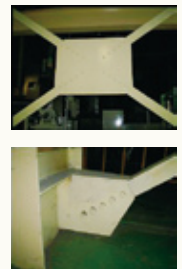
鉄骨の耐震補強工事 (筋交い・ボルトの補強)
