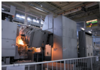
館林鋳造所内の工程の様子
