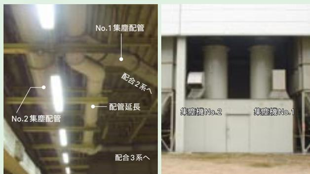
(左) ダンパー操作と配管延長で集塵機配管系統を一台に集約
