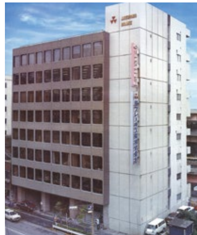
日本橋に建設した本社社屋(1971)
