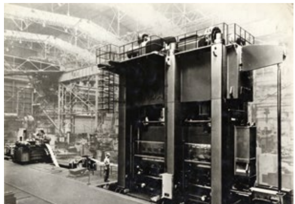
岩槻製造所、2,500t トランスファープレス(1967)
