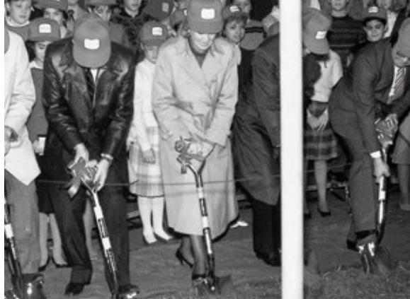
Ambrake Corporation 建設地での鉄入れ式(1986)
