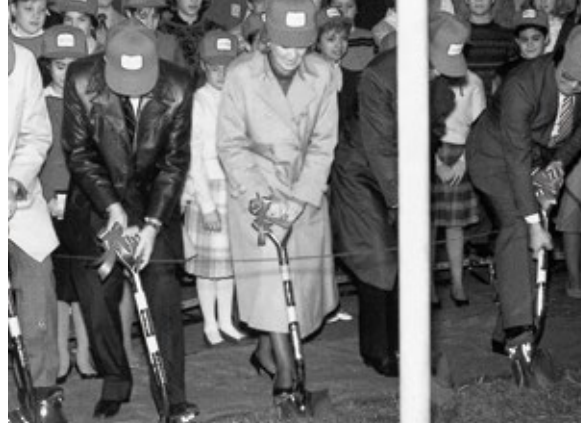
Ambrake Corporation 建設地での鉄入れ式(1986)
