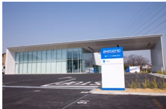
中部オフィス「Akebono Central Pier(ACP)」竣工(2008)
