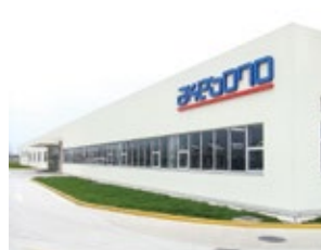
曙光制動器(蘇州)有限公司 [Akebono Corporation (Suzhou)] 江蘇省蘇州市工業園三区長陽街 汀蘭港168号, China 【設立】 2004年11月 【事業内容】 ディスクブレーキパッドの製造およびセールス
