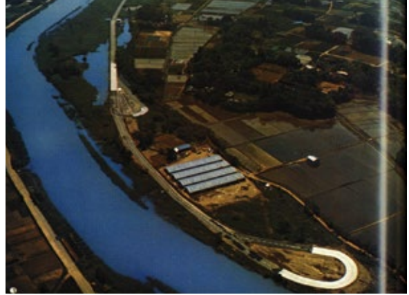
岩槻製造所近くの元荒川沿いにテストコース完成(1967)
