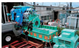
Ai-Cityでの設置工事
