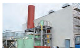
建設中の発電設備（山形製造株）
